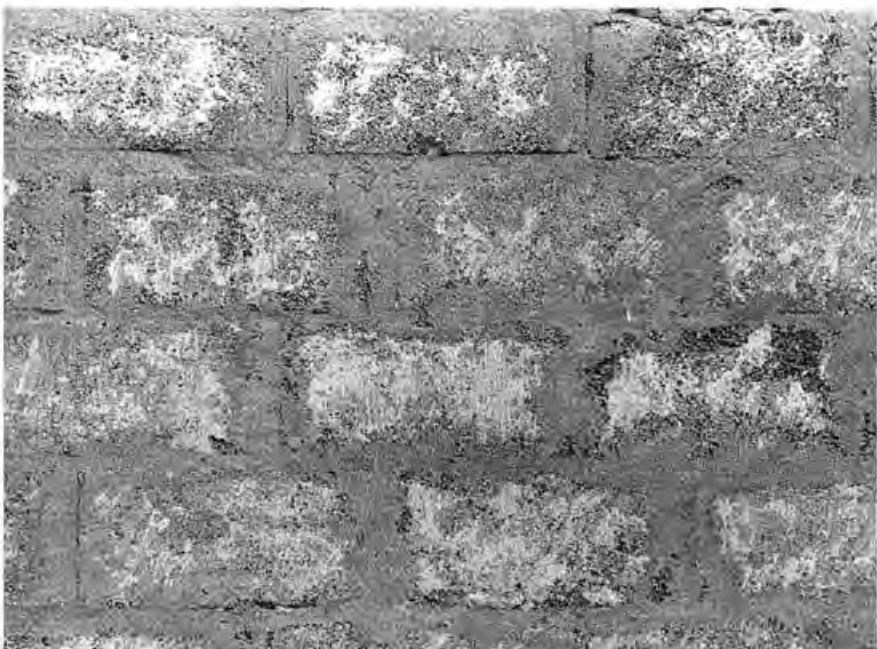
Photo 2 Support acceptable. Il ne subsiste pas de couche continue de plâtre et l'enduit peut adhérer directement sur la maçonnerie sur la plus grande partie de la surface.
