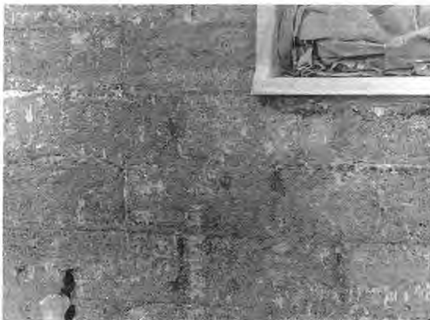
Photo 1 Support bien décapé. Les traces de plâtre sont très limitées.
