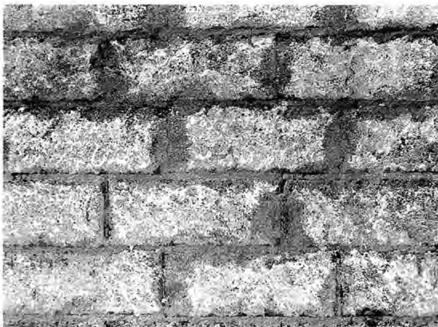
Photo 4 Les traces de plâtre recouvrent la plus grande partie de la surface. Un décapage complémentaire par brossage mécanique, bouchardage ou sablage est nécessaire.
