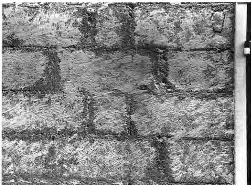
Photos 5 et 6 Il subsiste une couche continue de plâtre sur la plus grande partie de la surface. Un décapage complémentaire est nécessaire.
