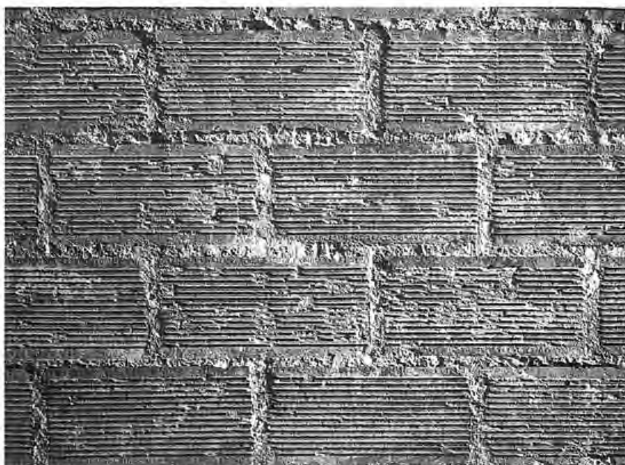
Photos 3 et 4 Support acceptable sous réserve que les restes de plâtre sur les joints de maçonnerie n'aient pas plus de 2 mm d'épaisseur et 20 cm 2 de surface unitaire.
