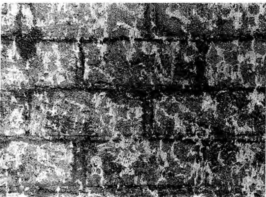
Photo 3 La plus grande partie de la surface est décapée mais il subsiste des plaques d'enduit à base de plâtre. Ce support est acceptable sous réserve que ces plaques n'aient pas plus de 2 mm d'épaisseur et 20 cm 2 de surface unitaire.
