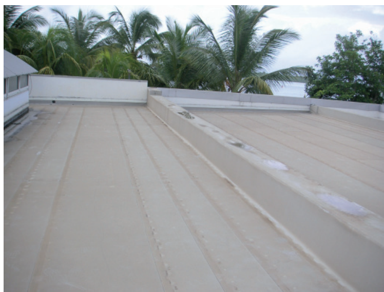
Membrane synthétique fixée mécaniquement à la Guadeloupe
