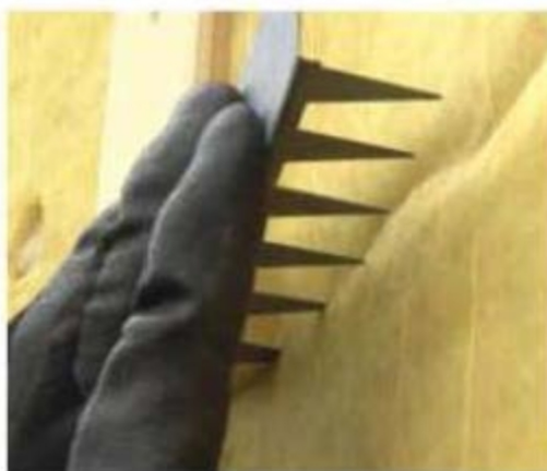
Figure 14d : Exemple d'assemblage par attache spéciale à dents fixée mécaniquement
