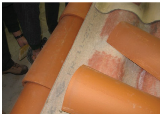
Pose du mortier sur le 1 er rang de tuiles
