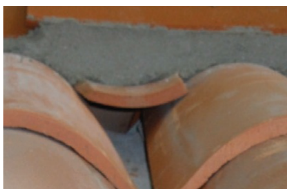
Détail du dessous du casson dans le cas 1 (faîtage ventilé)
