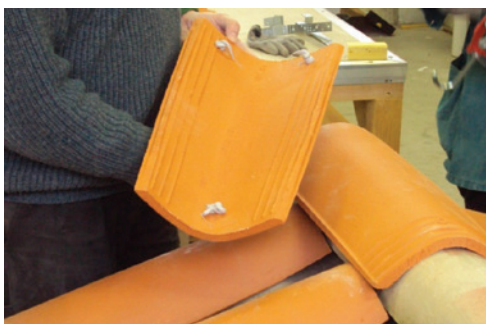
Position des plots de mastic colle pour la fixation des faîtières
