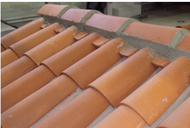
Figure 14 – Faîtage scellé sur casson
