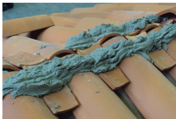
Dressage du mortier par embarrure
