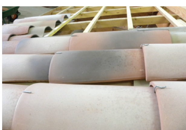
Positionnement de la tuile adjacente
