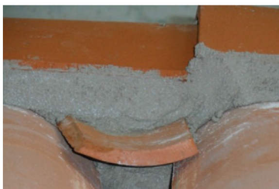
Détail du dessous du casson dans le cas 2 (faîtage non ventilé)
