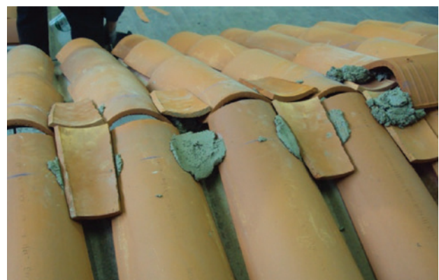
Figure 16 – Faîtage scellé non ventilé – pose à 1 tuile
