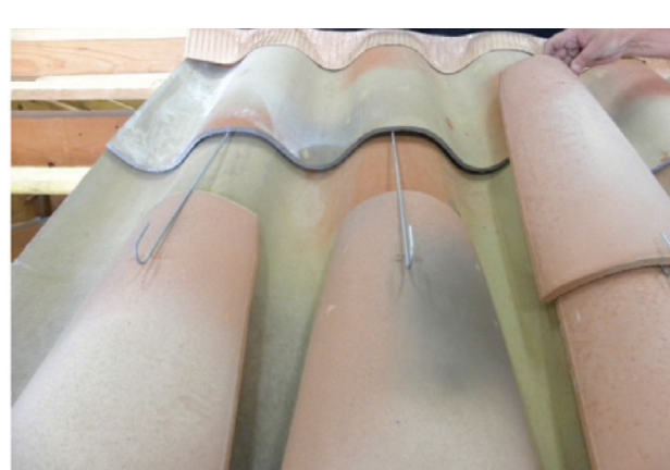
Mise en place des crochets S
