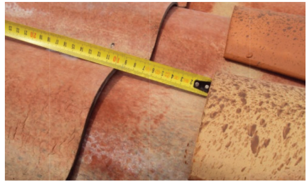
Figure 6 – Décalage des recouvrements
