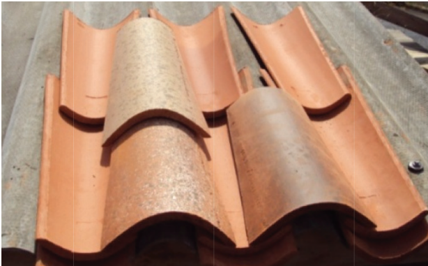
Figure 5 – Pose à 2 tuiles
