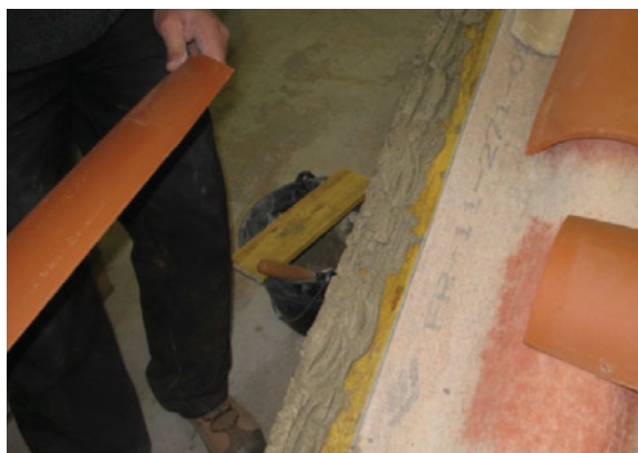
Pose du mortier sur la volige
