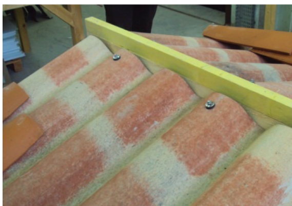
Mise en œuvre d'une lisse de rehausse
