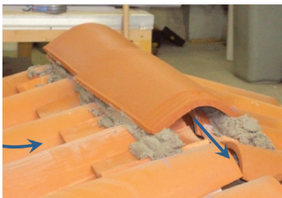
Pose des faîtières - Ventilation au faîtage par entrée d'air sous cassons (cas 1)
