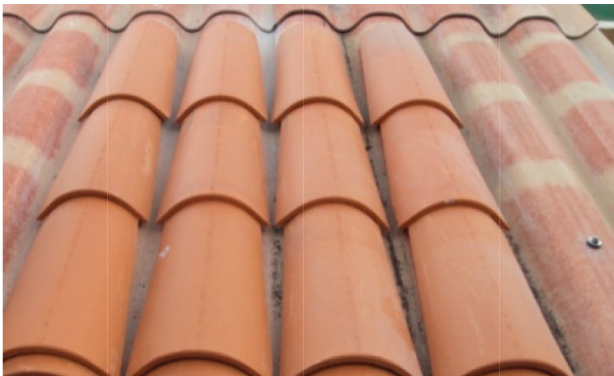
Figure 4 – Pose à 1 tuile
