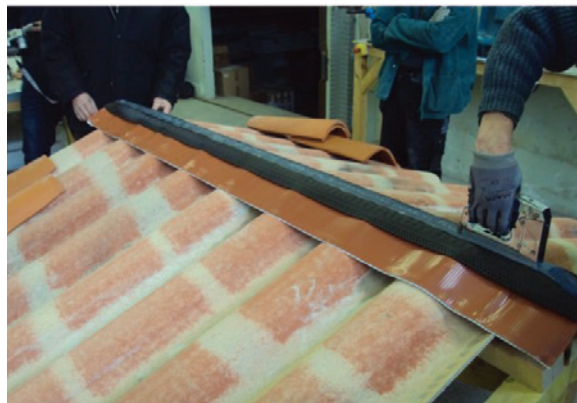
Fixation du closoir sur la lisse de rehausse
