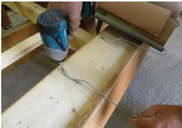
Fixation crochet à œil cambré à l'égout
