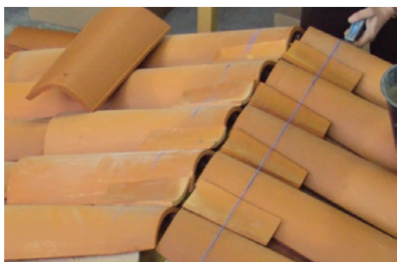
Traçage pour dressage du mortier
