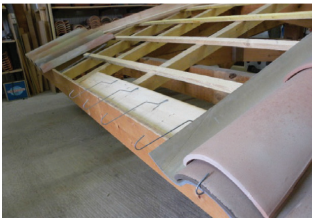
Emboîtement de la plaque et de la tuile
