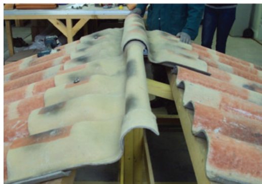
Pose du grand élément G de la faîtière
