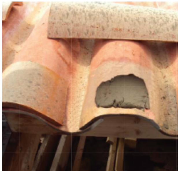
B. Pose du mortier au centre
