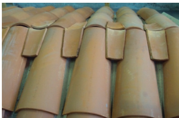
Pose des cassons dans le cas d'un faîtage ventilé (cas 1)
