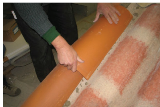
Pose du 2 e rang de tuiles
