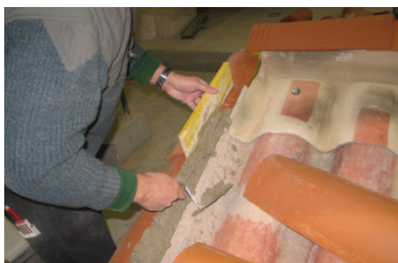
Pose du 1 er rang de tuiles
