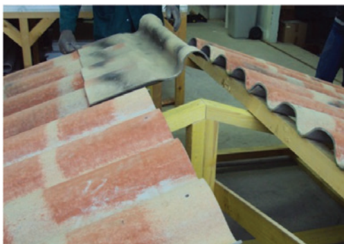
Pose du petit élément P de la faîtière
