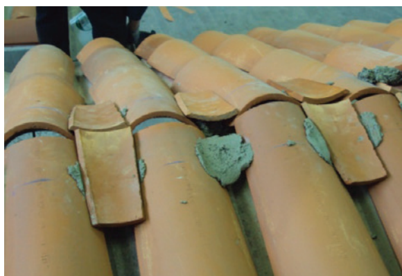
Pose des cassons dans le cas d'un faîtage non ventilé (cas 2)
