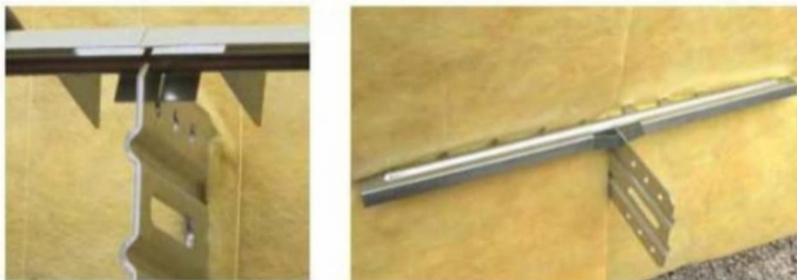
Figure 10c - Exemple d'assemblage par attache spéciale à dents clipsable
