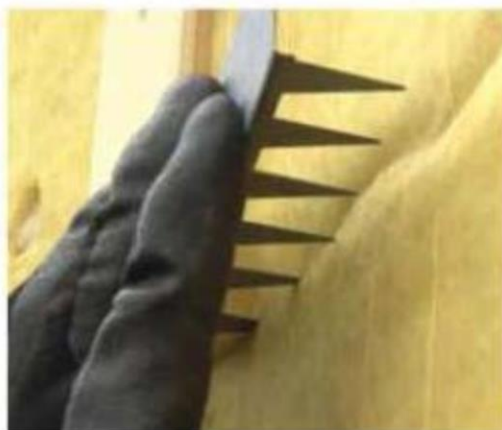
Figure 10d - Exemple d'assemblage par attache spéciale à dents fixée mécaniquement
